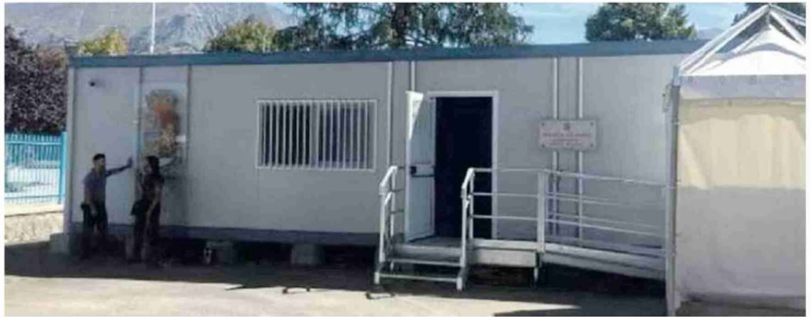
L'attuale sede della polizia stradale di Amatrice
