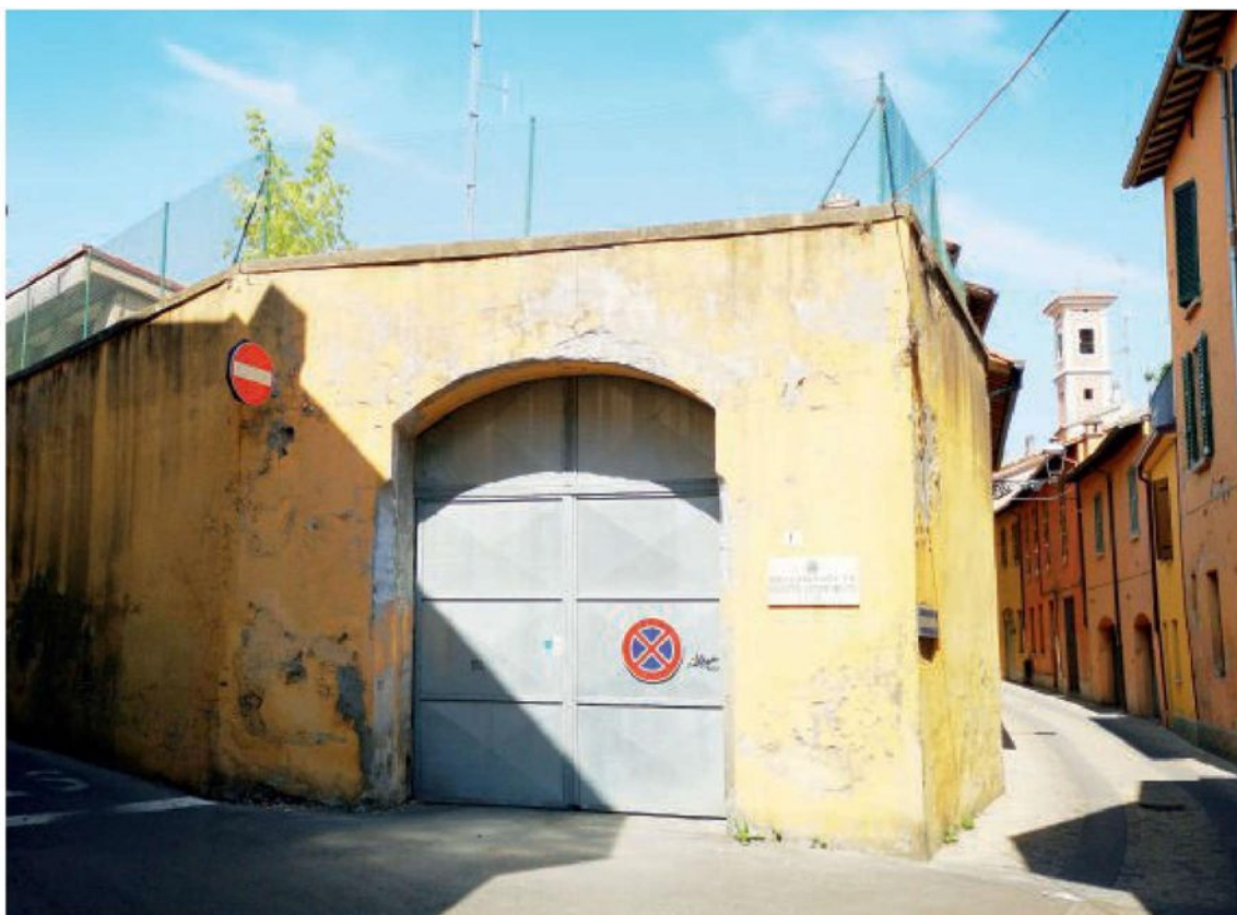
Il portone carrabile del Commissariato, attualmente rotto FOTO MMPH
